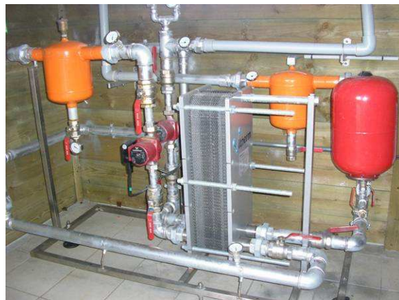
Echangeur de chaleur au niveau d'un bâtiment à canards – SCEA Bois Brillant (49) - © AILE
