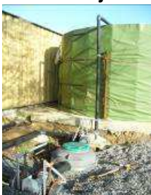
Photo 1 : Cuve de stockage des jus
